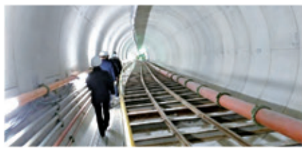
▲整備が進む楠葉雨水貯留施設
